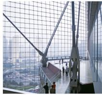
工程設計有時不只是一棟大廈的裡子,更可作為吸睛的面子。這座商業大廈完美結合建築與工程,其巨型支點式玻璃幕牆,可謂最有代表性,幕牆更將大廈內外連為一體。面向東北的平台,引入充沛陽光,而外牆垂直的遮陽板(brise-soleil)則可防止大廈過熱,也成為設計一大特色。建築內部同樣精彩,看似隨意地運用木材與混凝土裝飾,令平凡的辦公室變得有趣。
